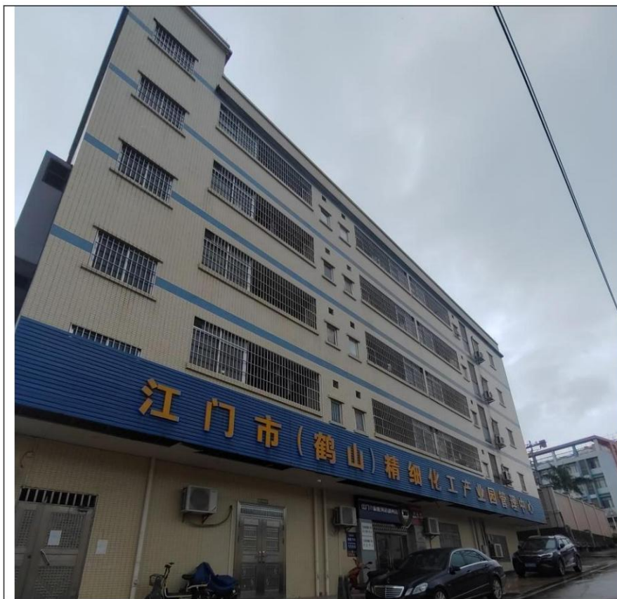
项目西北面：江门市（鹤山）精细化工产业园管理中心
