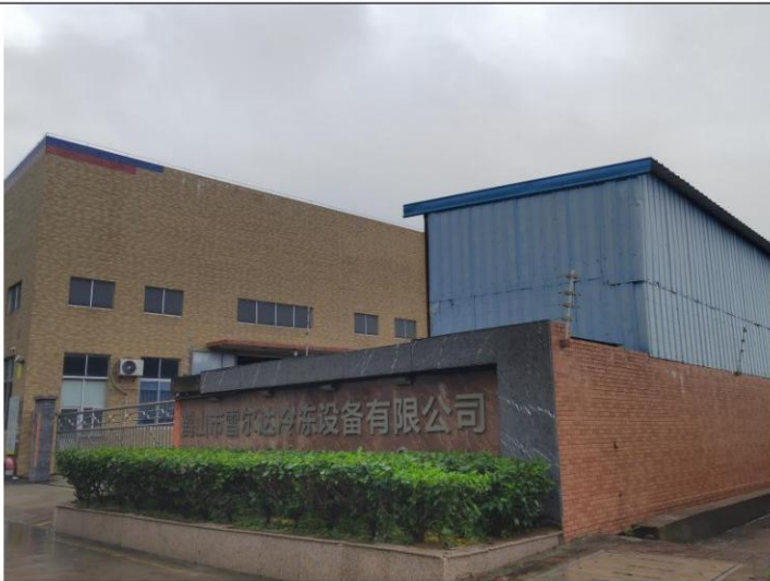
项目东北面：鹤山市雪尔达冷冻设备有限公司
