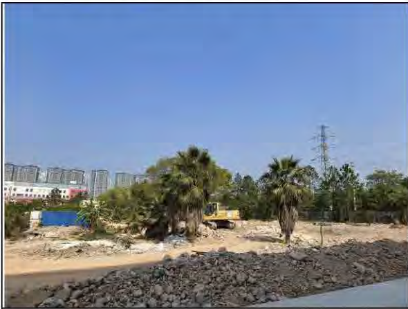
项目东北面：拟建工业厂房（现状为空地）
