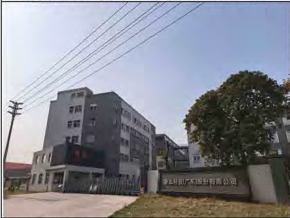
项目西南面：智弘科技(广东)股份有限公司
