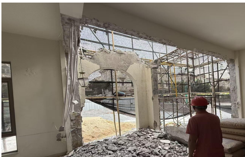
图4 靠近门廊一侧墙体已被拆除
