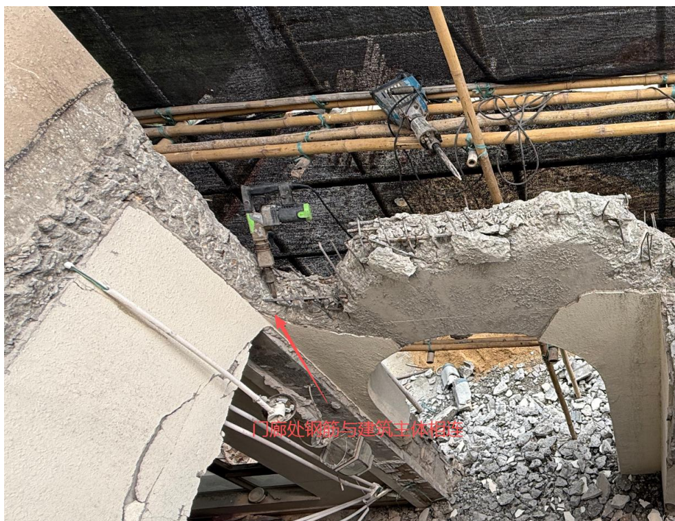
图 5 现场门廊的细部图片
