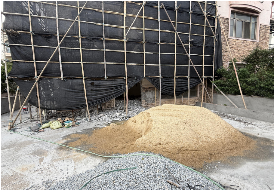
图 1 鹤山市沙坪街道碧桂园鹤起香泉 25 街 16 号装修工程施工现场
