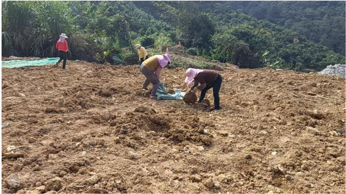
复垦施工照片2
