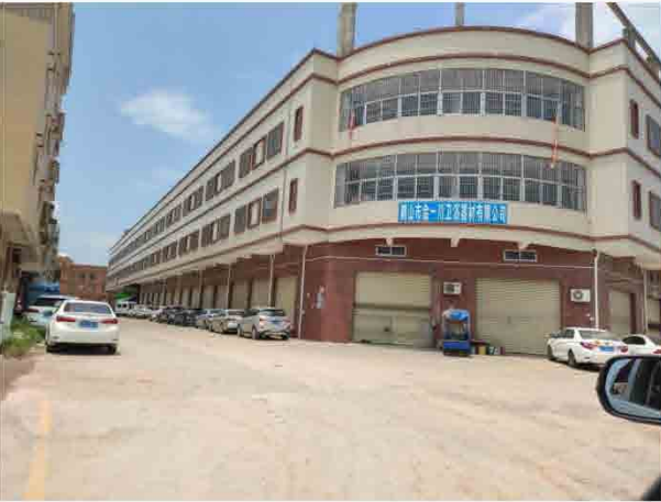
项目西面 2：江门市金一川卫浴器材有限公司
