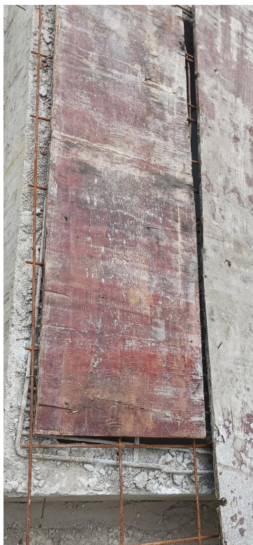
图 4 BOPP 薄膜及特种胶带生产项目- BOPP 薄膜车间锅炉房天面层使用的井口盖板
