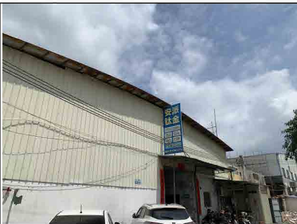
项目东北面：鹤山市址山镇安派卫浴厂
