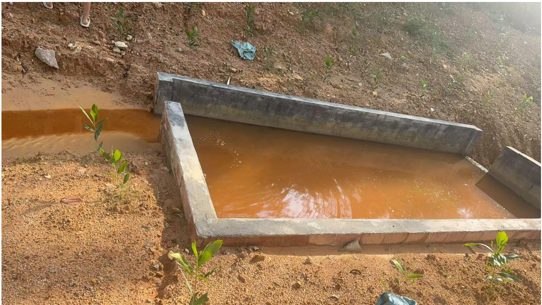
照片 3 沉砂池（2025 年 6 月）
