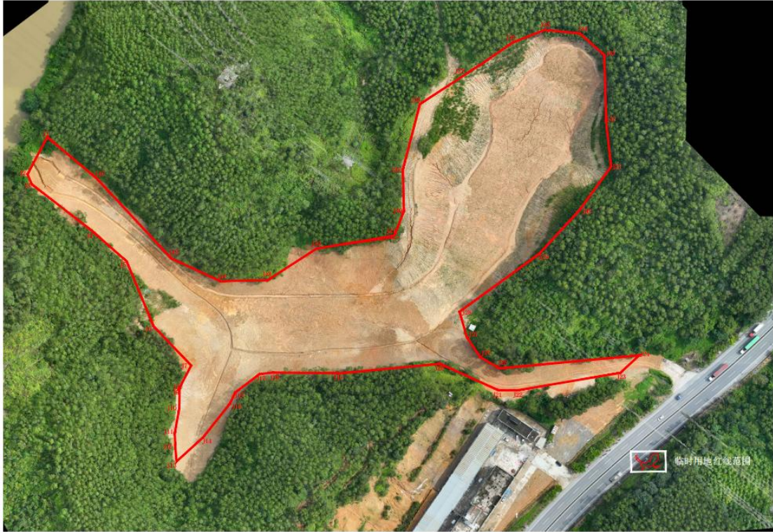
图3 临时用地土地利用情况航拍影像图（2025年6月）
