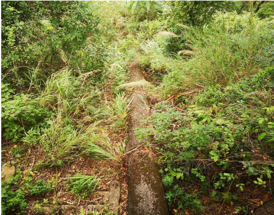
图 5-3 混凝土管破碎、拆除
