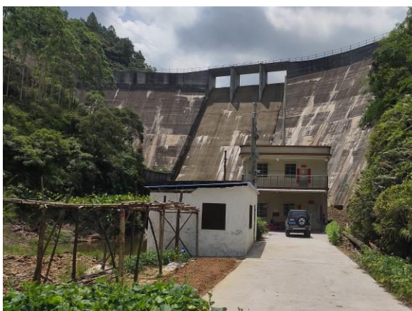
图 4：厂坝间减脱水河段
