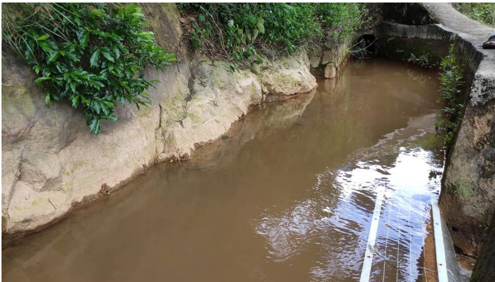
图 5-1 渠首进水口（封堵及溢流堰开槽部位）
