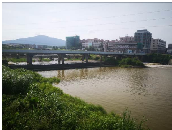
图 4：厂坝间减脱水河段
