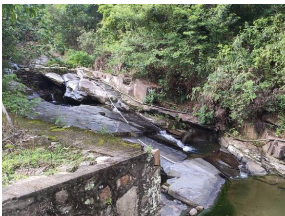
图 4：厂坝间减脱水河段
