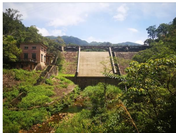
图 4：厂坝间减脱水河段
