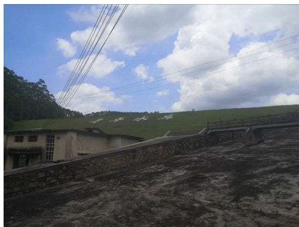
图 4：厂坝间减脱水河段
